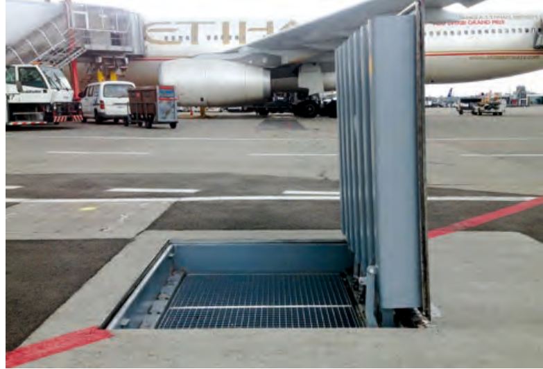
Schwerlastabdeckung, Klasse F 900, Genf
