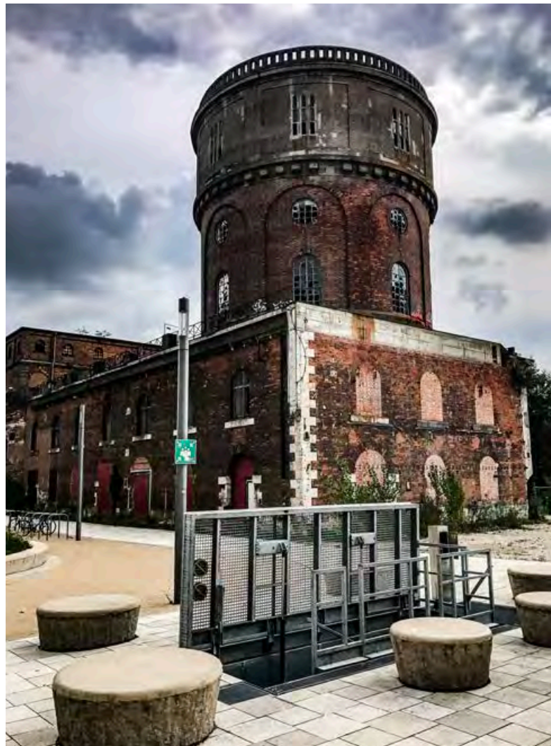
Notausstieg mit hydraulischem Antrieb als Gitterrost, Ingolstadt
