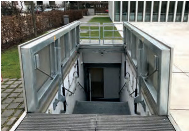
Notausstieg mit ausgepflastertem Deckel, Frankfurt
