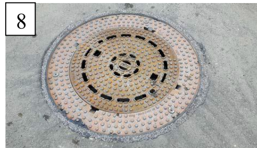
8 Die Abdeckung kann nachdem der Schachtvergussmörtel eine Mindestdruckfestigkeit von 10 N/mm 2 erreicht hat (Herstellerangaben beachten) für den Verkehr freigegeben werden
