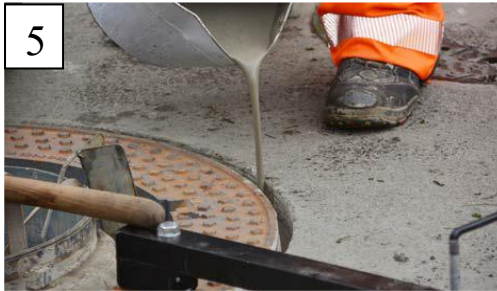
5 Nach Einbau einer Innenschalung Fugen bis ca. 4 cm unter Oberkante mit Schachtvergussmörtel vergießen
