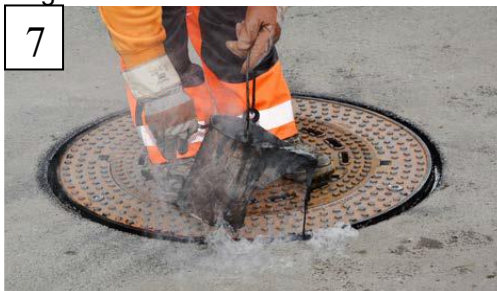
7 Die Anschlussfuge dauerelastisch vergießen
