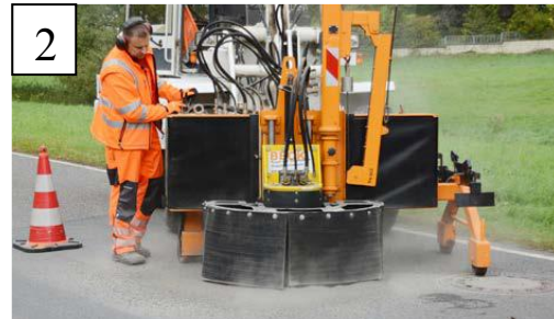
2 Schadhafte Abdeckung ausbauen
