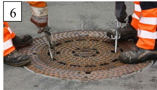
6 Nach dem Entfernen aller Einbauhilfen den Deckel einlegen.
