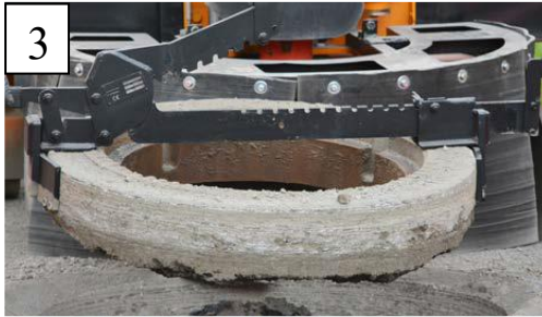
3 Schadhafte Abdeckung ausheben
