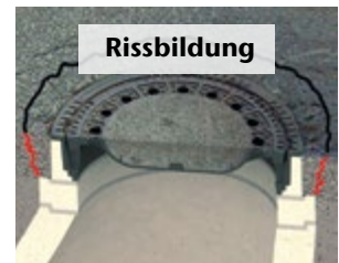
Durch Schwingungen erzeugte Risse an herkömmlichen Schachtabdeckungen
