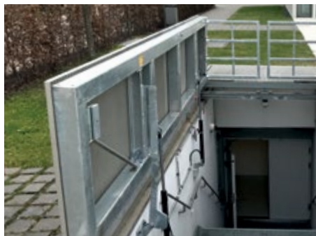
Großformatige, rechteckige Abdeckungen auf Bauwerksöffnungen
