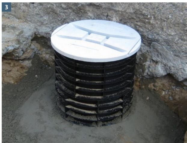
Unterteil auf Fundamentbeton C 12/15 versetzt und bis zur ersten Querrippe mit Rückstütze einbauen.
