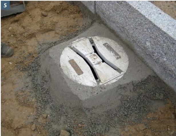
Erhöhtes Betonaufleger C 12/15 umlaufend für Aufsatz zur Lastaufnahme bzw. -ableitung mithilfe der Schalungshilfe ausbilden.
