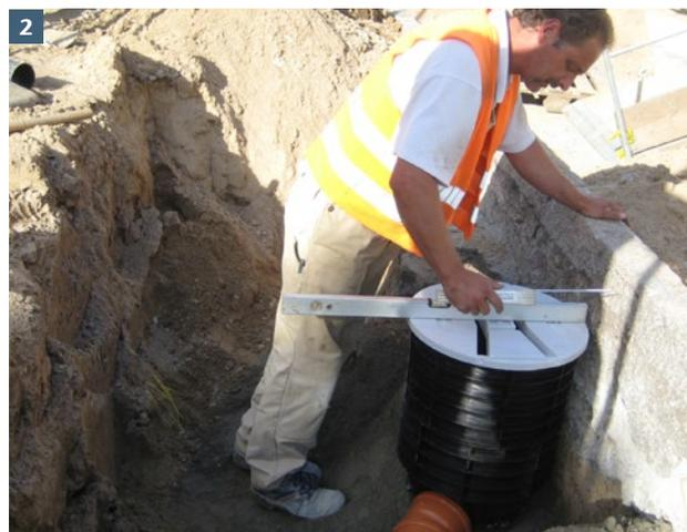
Optimale Ausrichtung des Ablaufs inkl. Aufsatz durch die Drehbarkeit, Teleskopierbarkeit und Anpassung an die jeweilige Quer- bzw. Längsneigung.
