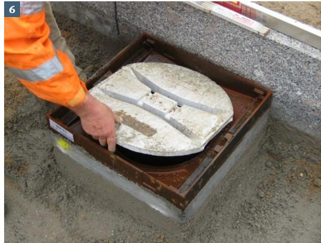
Aufsatz mit Betonaufleger. Die Kunststoffrippen müssen vollständig mit Beton verfüllt sein. Die EPS-Schalungshilfe kann nach Abknicken an den Sollbruchstellen als Verschlussdeckel gegen Schmutzeintrag in der Bauphase eingelegt werden.
