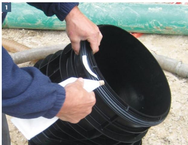
Vorbereitung der Oberteile durch Auftragen des Gleitmittels vor dem Ineinandersetzen.
