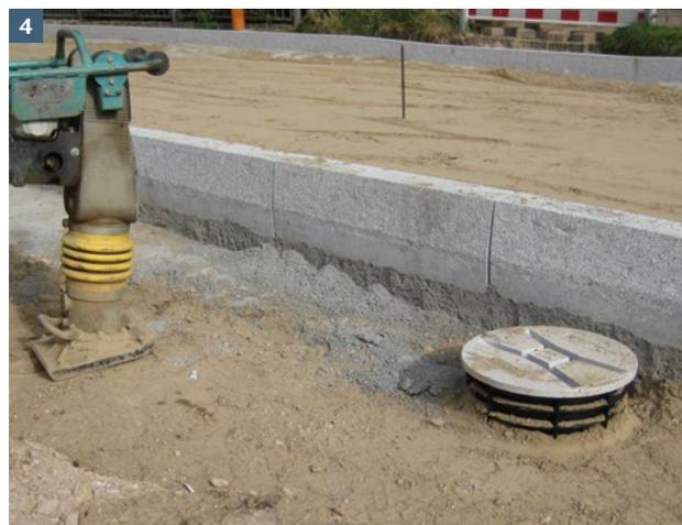
Verfüllen nach DIN EN 1610 mit entsprechendem Verfüllmaterial nach DIN 18196. Verdichten mit leichtem Verdichtungsgerät bis zur Markierung „Unterkante Beton“ auf dem obersten Kunststoffelement.
